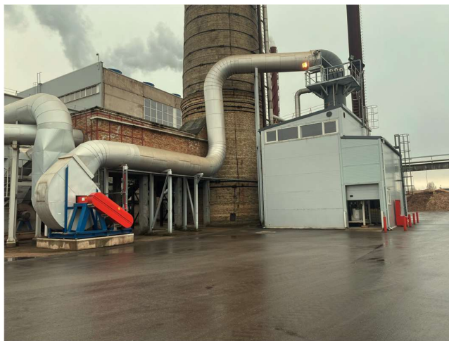
62 pav. Elektrostatinio kietųjų dalelių filtro įrengimo vieta
